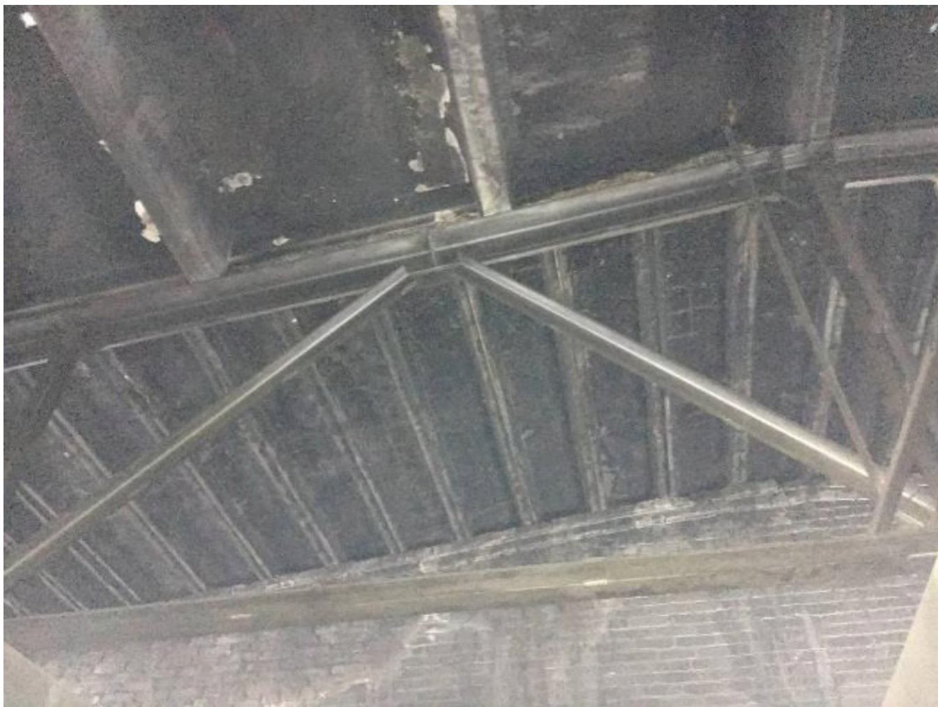
Фото 5. Металлические фермы и плиты покрытия.
