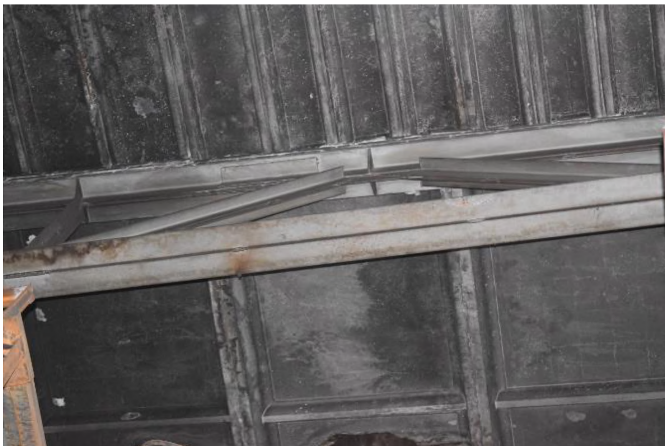
Фото 7. Металлические фермы и плиты покрытия.
